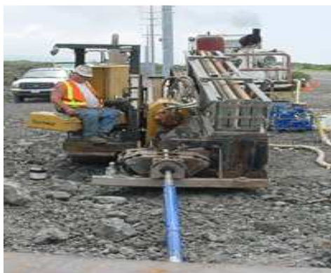
Fori di perforazione direzionale al di sotto del fondo del serbatoio per l'installazione dei tubi in PVC fessurati, Schedule 80.
